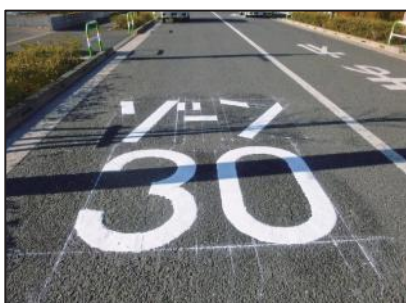
路面標示の例
