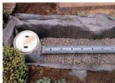
図：雨水浸透ます（上） 雨水浸透トレンチ（下）
