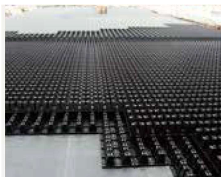
左：地下浸透貯留施設（出典：積水化学工業株式会社 HP）
