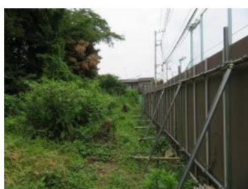
⑦東側境界部(北側を望む)
