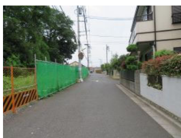
①北側道路(西側を望む)
