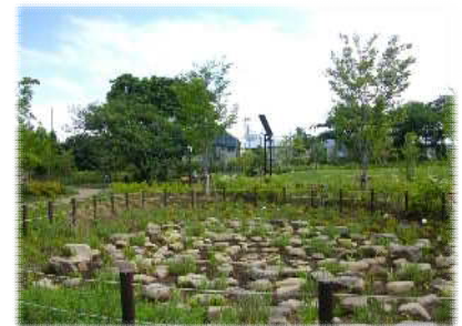
雨水貯留施設 (レインガーデン)
