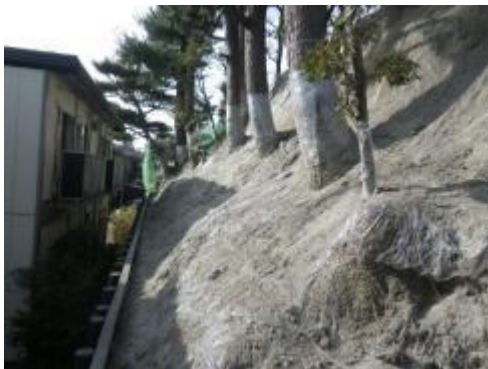
■長繊維補強土工施工例■
