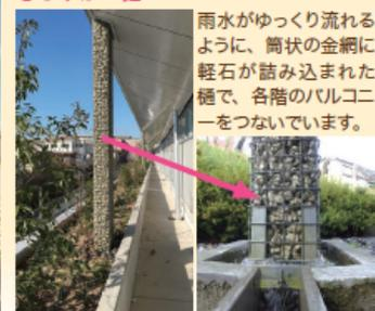
雨水がゆっくり流れるように、筒状の金網に軽石が詰め込まれた樋で、各階のバルコニーをつないでいます。
