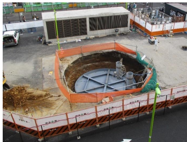
水槽の蓋を設置
