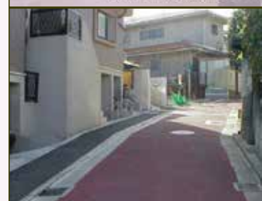
地区防災施設1号の片側拡幅 (2.7m→4.35m)
