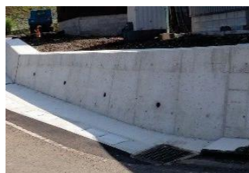
重力式コンクリート擁壁
