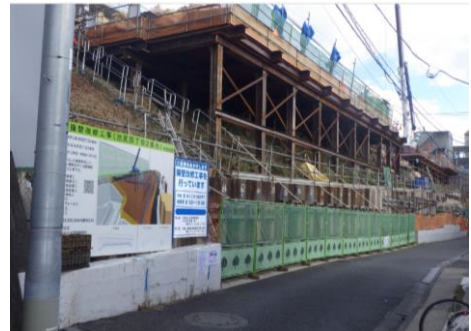
工事中 (令和7年12月現在)
