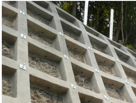
法面保護の施工例
