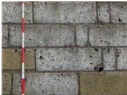
大谷石積み擁壁
