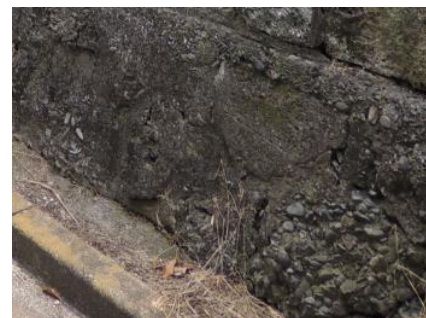
ガンタ積み擁壁
