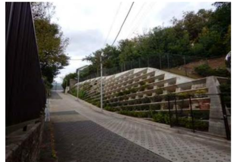
工事完了後 (野毛二丁目緑地)
