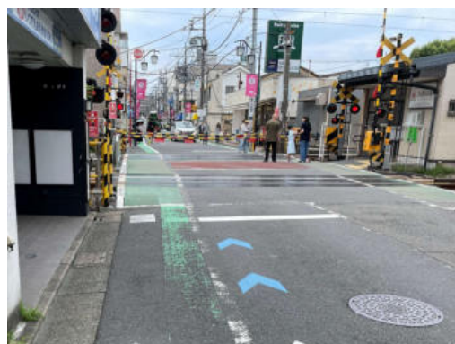
特殊な構造の踏切※9 (東急大井町線 自由が丘6号踏切)
