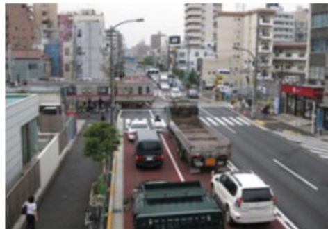
京成押上線 京成曳舟第1号踏切 (連立事業により除却済)
