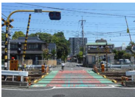
歩行帯カラー舗装 (JR中央線 裁判所踏切)
