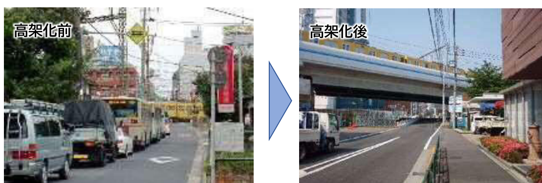
図 6-3 遮断時間が長い踏切の対策例【富士街道】 (西武池袋線(練馬高野台駅～大泉学園駅間)連続立体交差事業)
