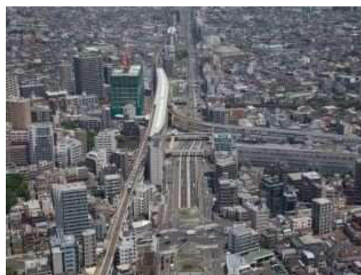
京急蒲田駅付近（高架化後）
