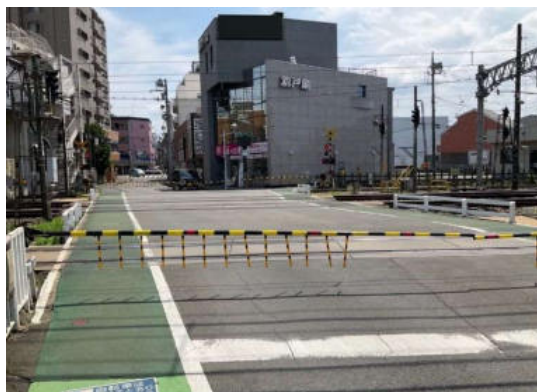
横断長が長い踏切 (西武新宿線 小平第1号踏切)
