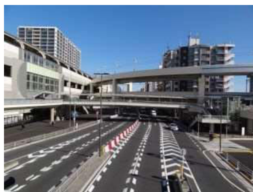
第一京浜（高架化後）
