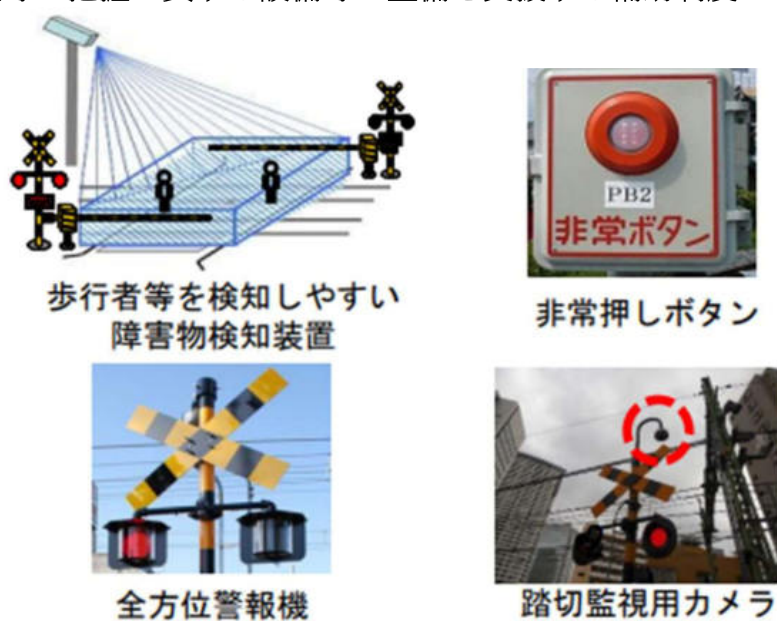
図 7-8 踏切保安設備の整備例
