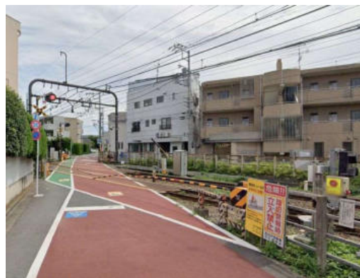
交差角度が小さい踏切 (京王井の頭線 永福町5号踏切)
