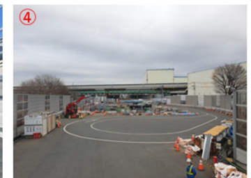
その他 換気所施工状況 (令和8年3月撮影)
