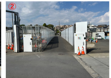
開削部 区道復旧状況 (令和8年4月撮影)
