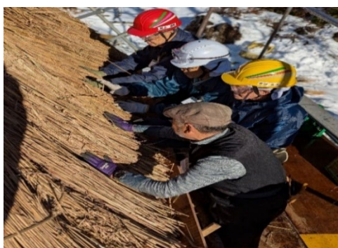
茅葺き職人による屋根葺き
