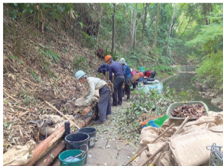
▲木や石など自然素材を活用しての再生作業
