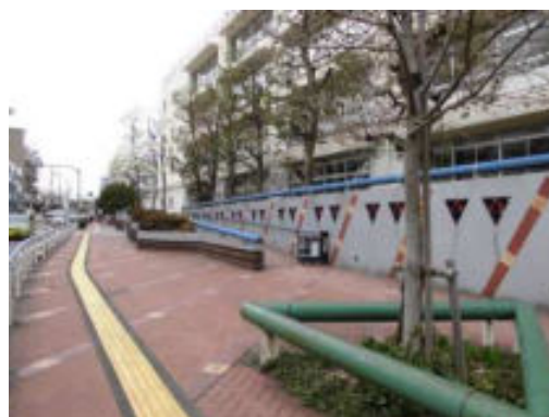
梅丘中学校と補助 154 号線を一体的に整備したみち。
