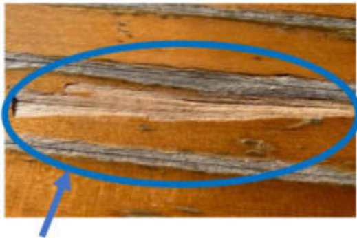
屋内運動場の床の破損（雨漏りが重なり、床が大きく剥がれた）
