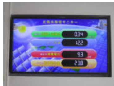
発電状況等モニターの例
