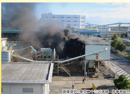
粗大ごみに混入した充電式電池が原因の粗大ごみ破碎処理施設での火災の状況
