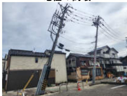
電柱の倒壊
