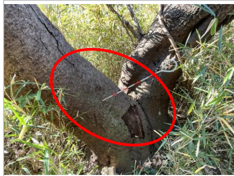
① 根元、樹皮欠損腐朽
