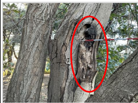
① 幹、樹皮欠損腐朽
