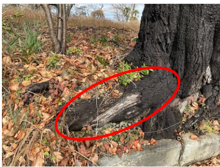
②根元、樹皮欠損腐朽
