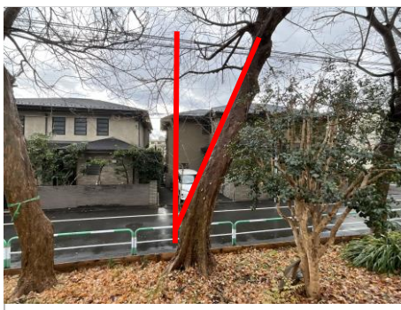
② 幹の傾きあり
