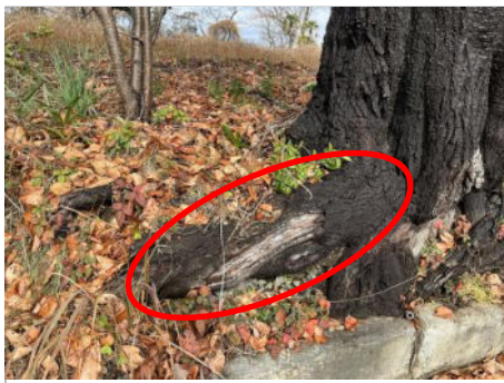
②根元、樹皮欠損腐朽
