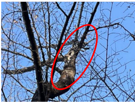
②大枝、樹皮欠損腐朽
