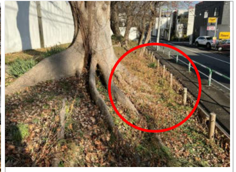
③ 大谷石側のり面
