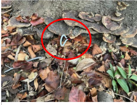
②鋼棒貫入異常
