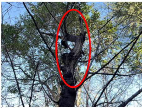
② 樹皮欠損腐朽
