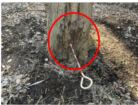
②根元、樹皮欠損腐朽
