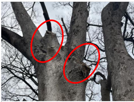
②幹、樹皮欠損腐朽
