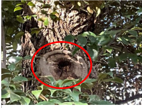
② 幹、樹皮欠損腐朽
