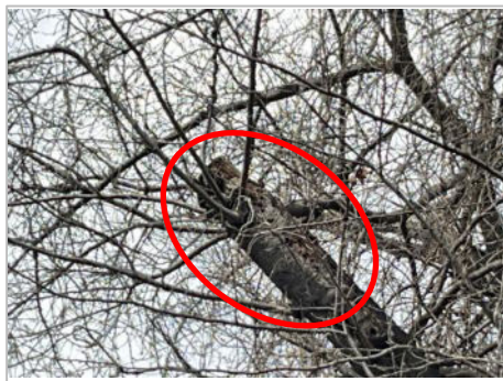
① 大枝、樹皮欠損腐朽
