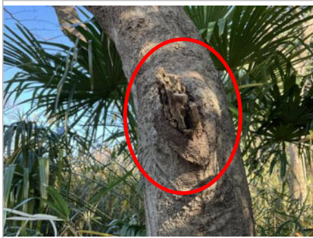
① 幹、樹皮欠損腐朽
