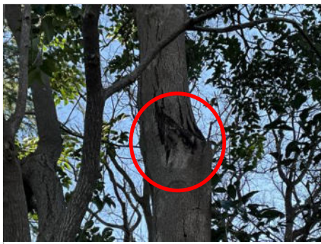
②大枝、樹皮欠損腐朽
