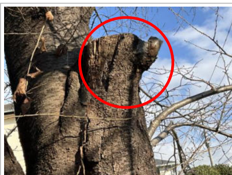
② 樹皮欠損腐朽
