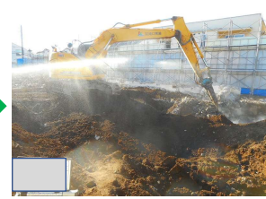
地下及び基礎解体
