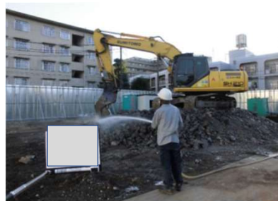
コンクリートガラ小割作業
