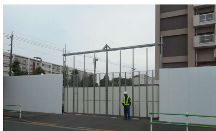
フラットパネル・パネルゲート・交通誘導員
