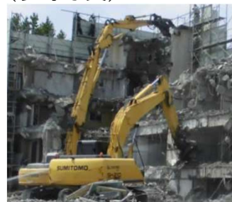
重機による解体作業
