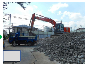
解体発生材搬出 (コンクリートガラ)
