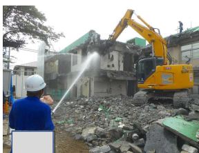
上屋解体 (中抜き)
