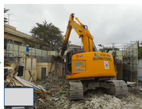
上屋解体 (壁倒し)
