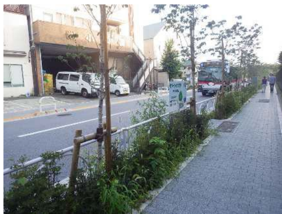
道路植栽帯を活用した雨水貯留浸透施設 (区画街路7号線)
