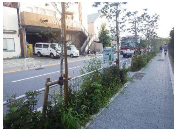
道路植栽帯を活用した雨水貯留浸透施設 (区画街路7号線)
