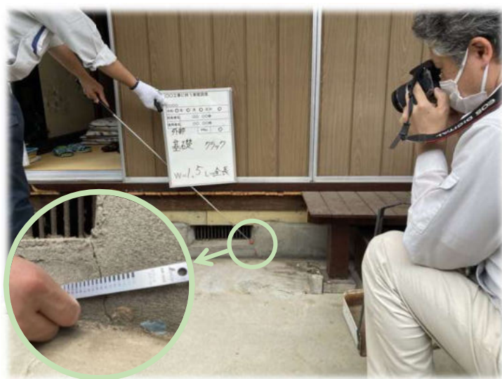
外壁・基礎調査
