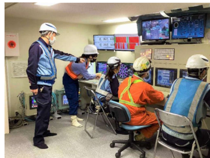
泥土圧の確認状況
