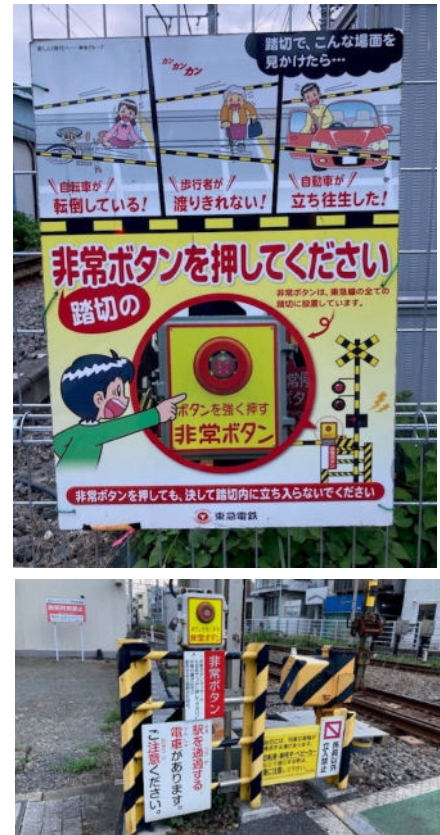
図 8 6 踏切の啓発看板と非常ボタンの例
