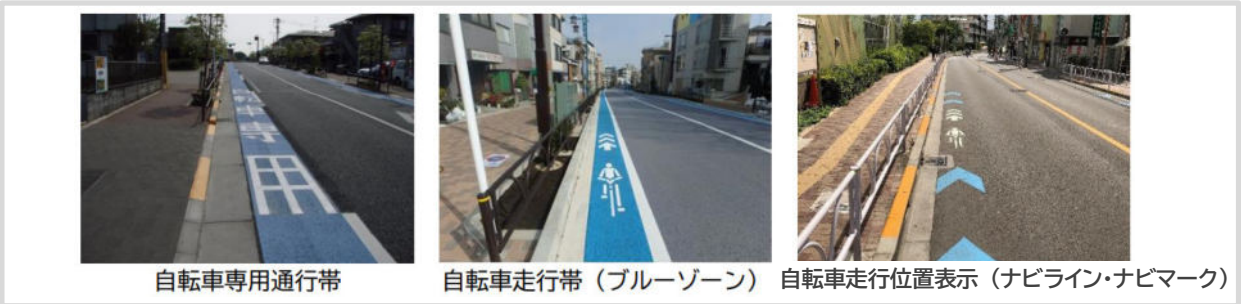
図 120 自転車走行環境整備（自転車通行空間の整備形態） 出典）世田谷区自転車活用推進計画及び自転車等の利用に関する総合計画（世田谷区、令和3年（2021年）7月）
