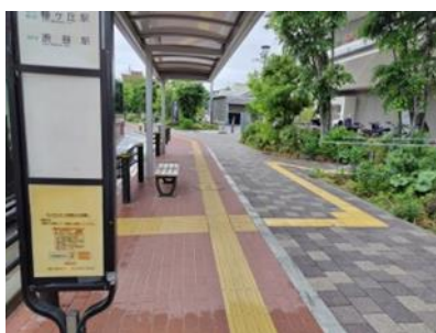
写真 4-3 歩道と施設の敷地の段差解消 連続した誘導用ブロックの敷設 （小田急梅ヶ丘駅周辺）
