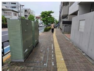
写真 4-4 無電柱化した歩道
