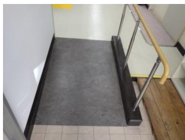
写真4-1 段差部分にスロープ、手すりを設置
