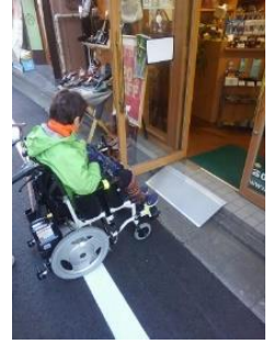
店舗への取り外し可能な簡易スロープの設置
