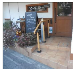
写真 4-10 改修事例 (手すりの設置)
