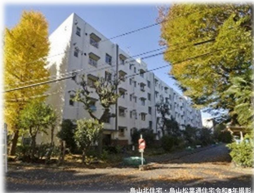
烏山北住宅・烏山松葉通住宅令和5年撮影
