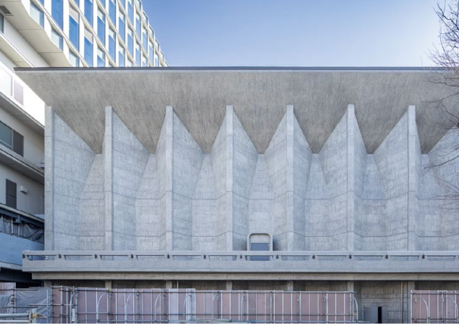
改修を終えた外壁。耐候性を向上させ、熟練工の作業により建設当時の姿に復原しました。
