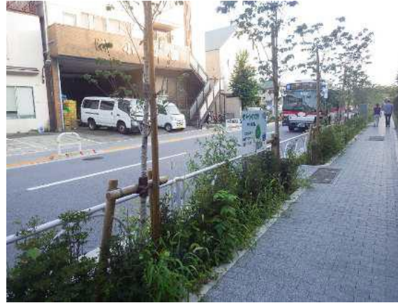
雨水貯留浸透する道路植栽帯 (区画街路7号線)
